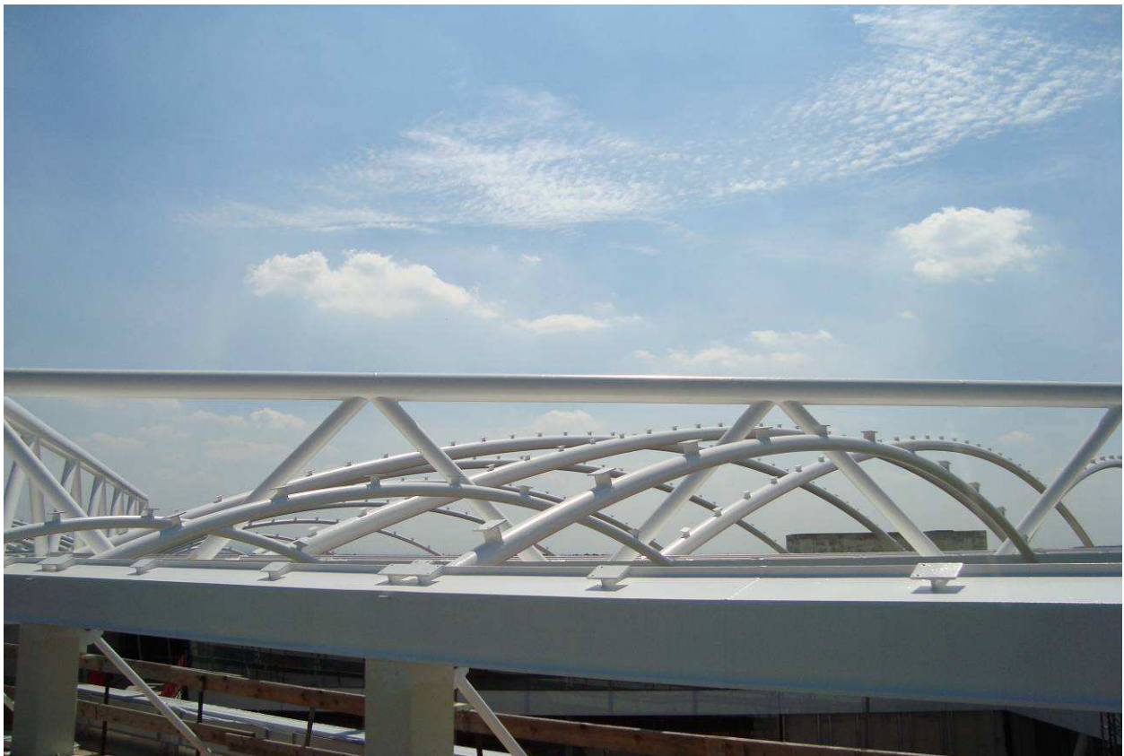
Bild 7: anspruchsvolle Architektur erfordert eine anspruchsvolle Planung , PSS
