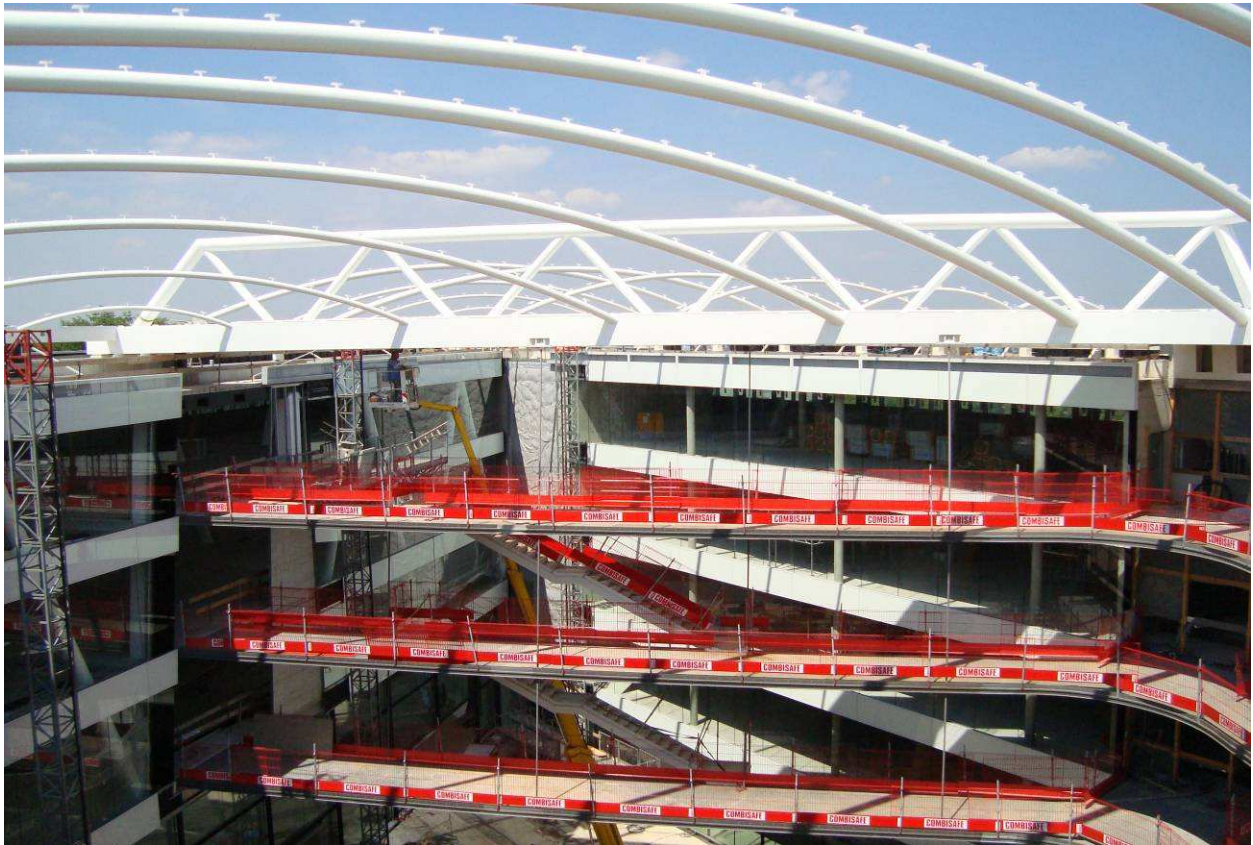
Bild 6: Umsetzung der Planung auf der Baustelle , PSS
