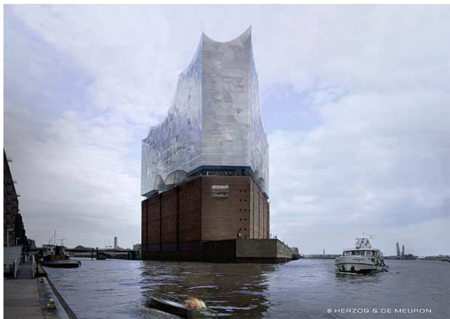
Bild 1 und 2: Elbphilharmonie Hamburg, © Herzog & de Meuron Dokumentfreigabe durch HdM 2010
